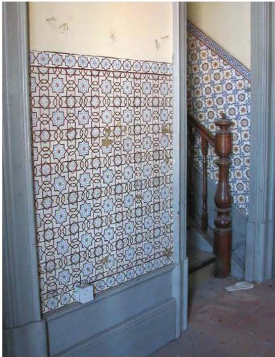
Fig. 14 – Silhares de azulejo no recebimento (Fotografia de 2009).
