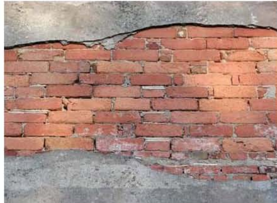
Fig. 5 – Materiais de refugo da Fábrica de Cerâmica das Devesas no palacete de António Almeida da Costa.
