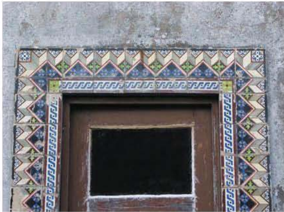
Fig. 6 – Azulejos da portaria.
