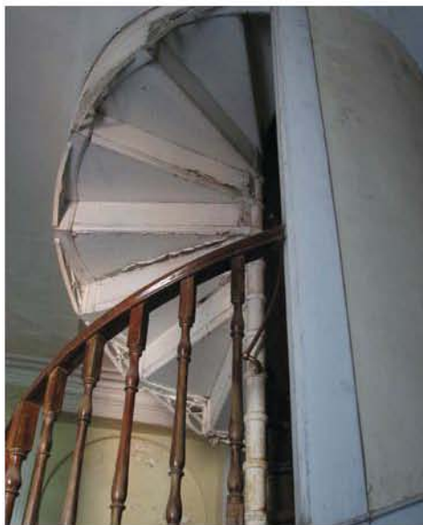
Fig. 23 – Escada de acesso ao mirante do palacete.
