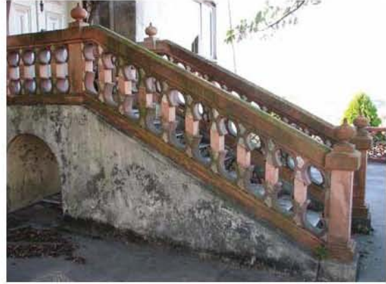
Fig. 7 – Escadaria do alçado nascente.
